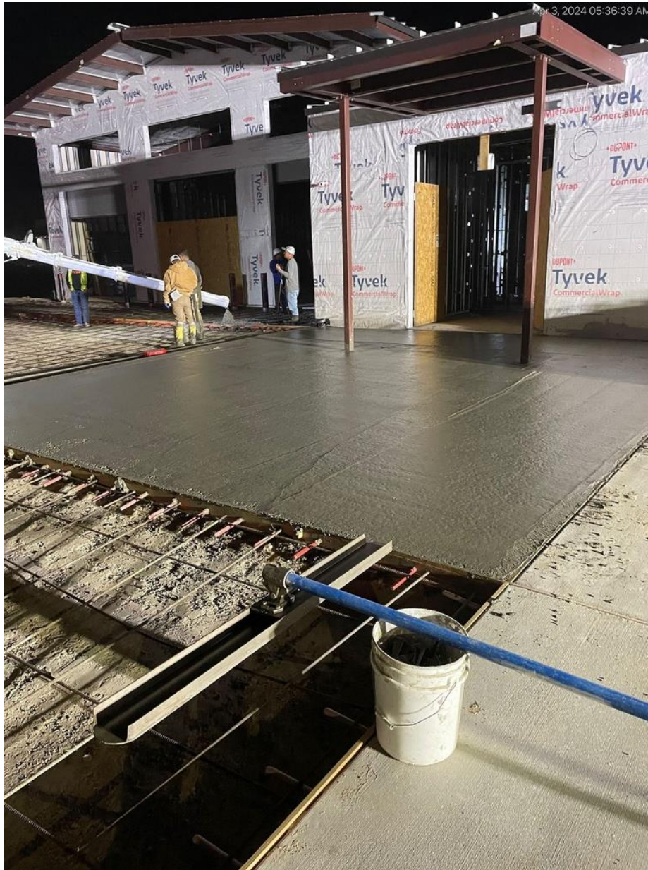
4/3/24 Remaining paving pour underway
