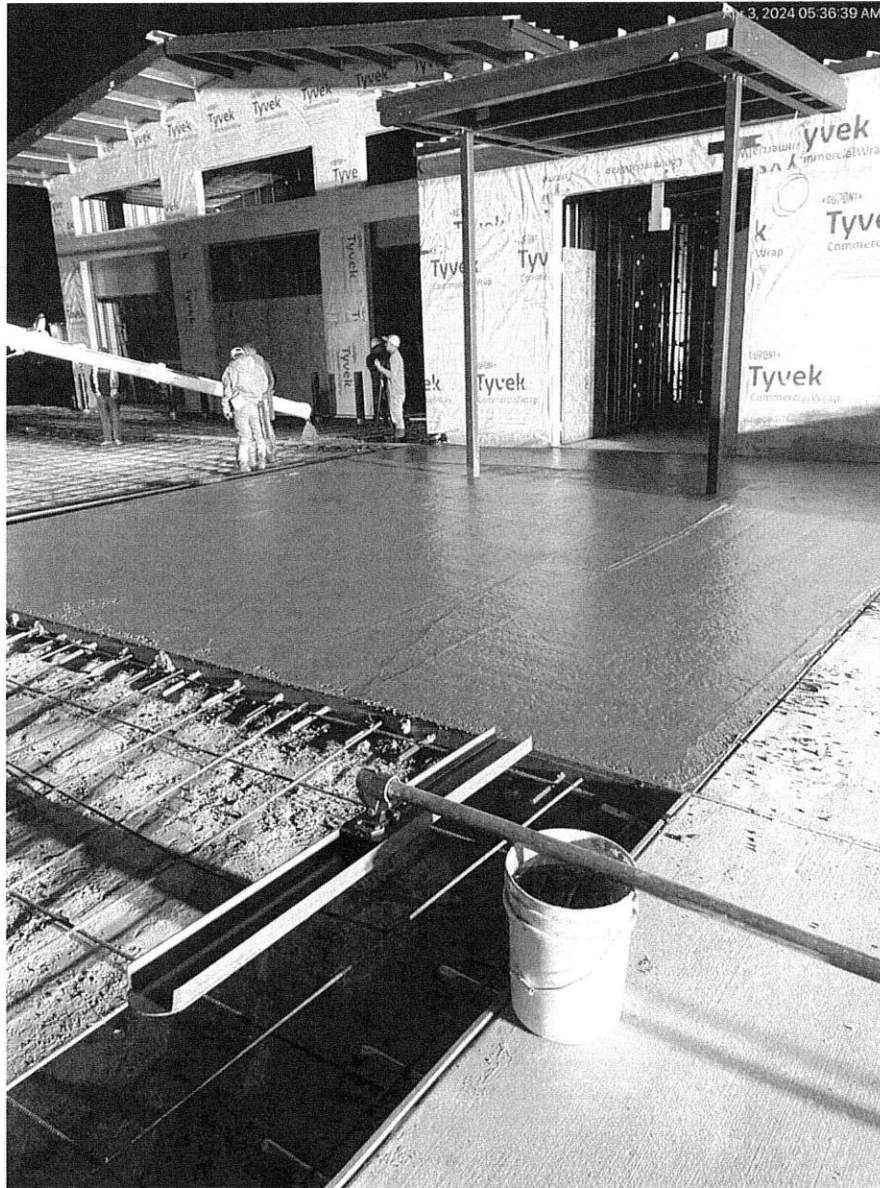
4/3/24 Remaining paving pour underway
