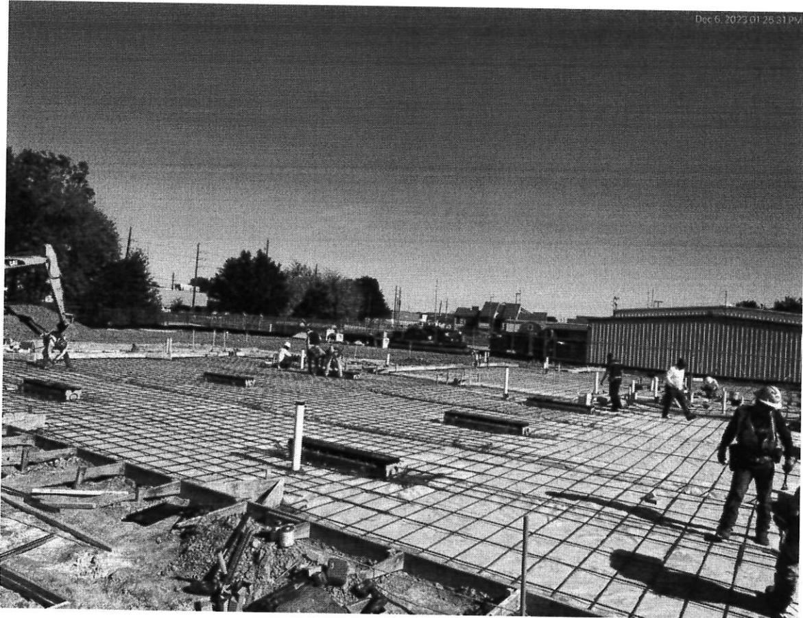
12/6/23 Foundation pour prep underway
