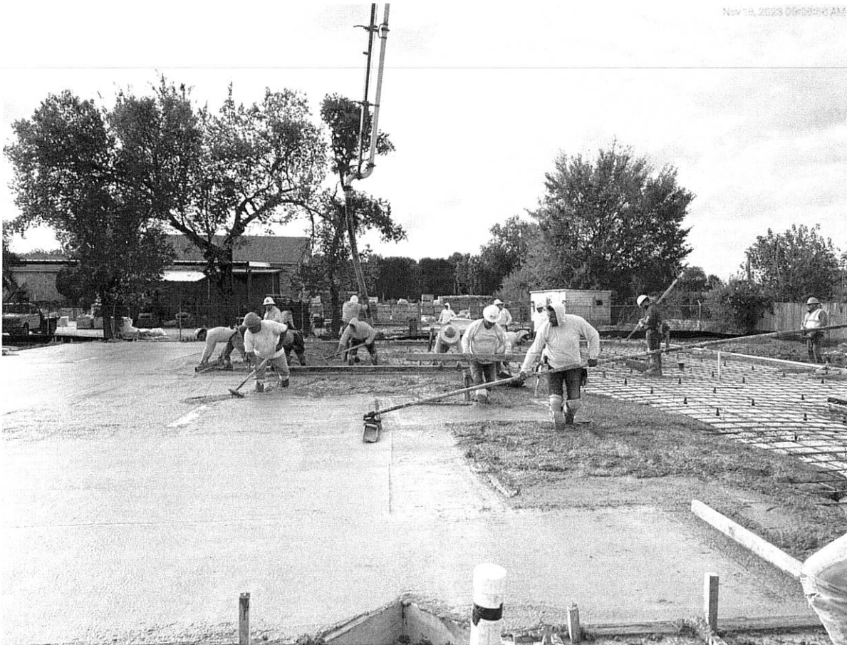
11/18/23 Slab on grade pour underway
