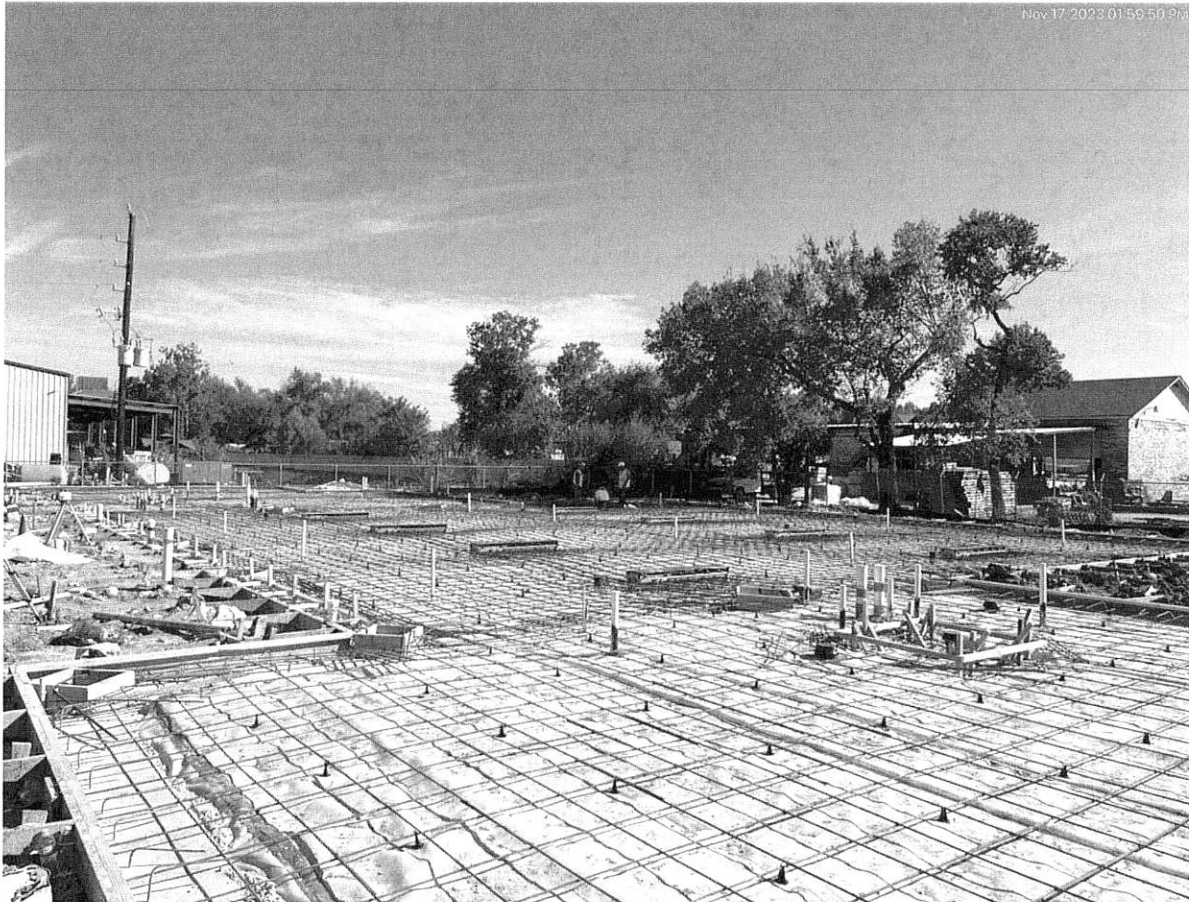
11/17/23 Final preparation for foundation pour
