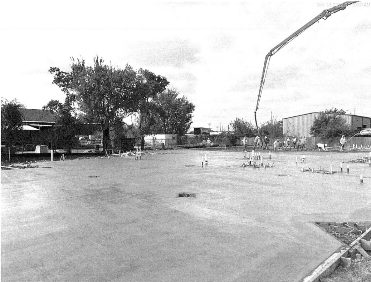
11/18/23 Slab on grade pour underway
