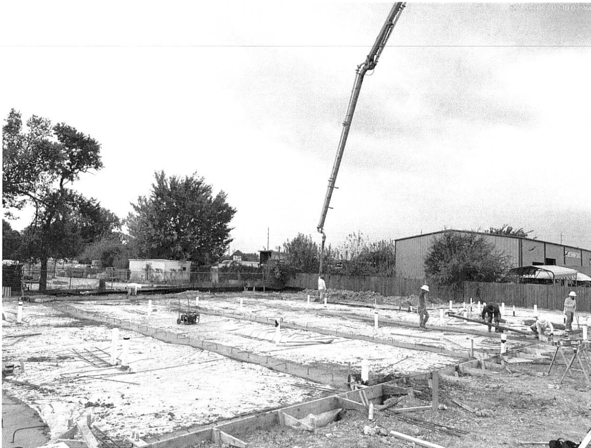
11/9/23 Foundation grade beam pour
